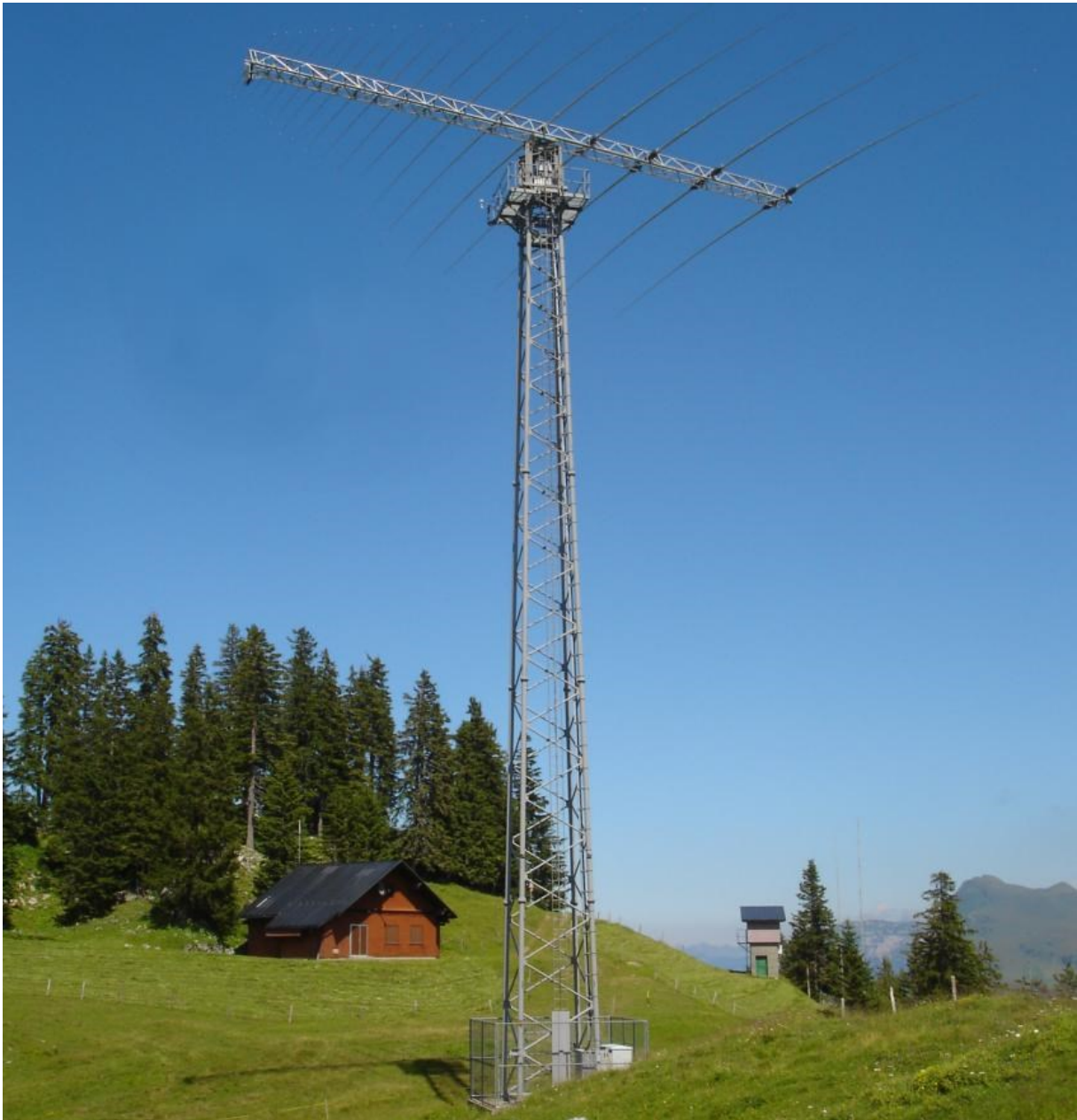
Die Botschaftsfunk Kurzwellen-Richtantenne LogPer LP-1001, 4-30 MHz auf der Klewenalp
