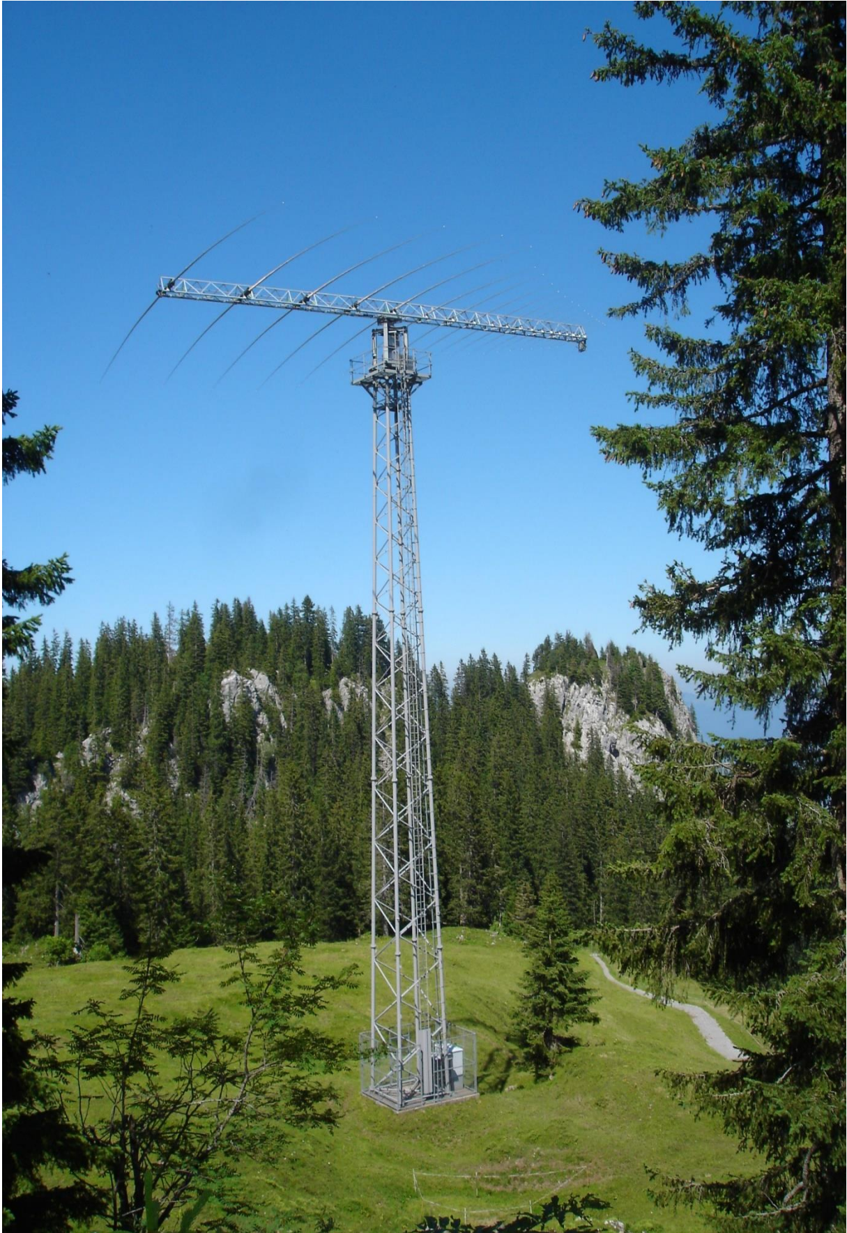
Die Botschaftsfunk Kurzwellen-Richtantenne LogPer LP-1001 , 4-30 MHz auf der Klewenalp
